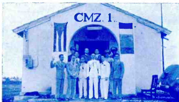
ENTRADA A LA PLANTA
