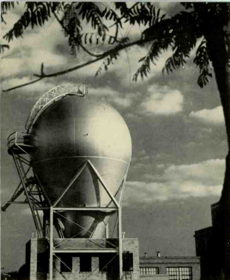
Fig. 1—The Westinghouse Van de Graaff generator.
