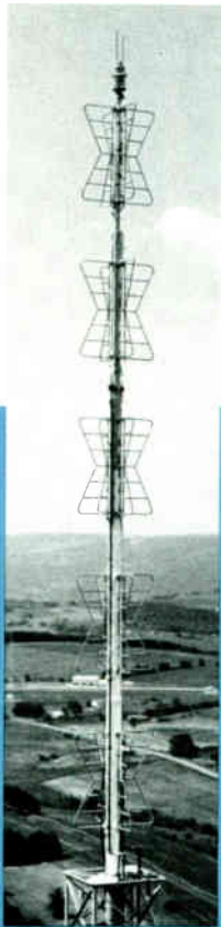
TAB Batwing VHF TV Antenna
