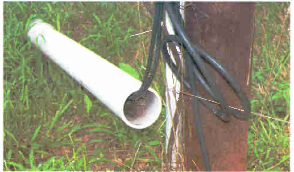
Fig. 6: Open conduits invite nests.
